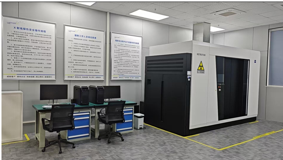
工业 CT 机铅房外顶部排风管道接入所在 C3 注塑车间通风系统
